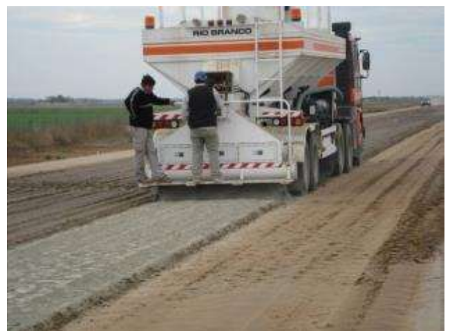
Foto 4: Distribución de cemento precisa y uniforme.
