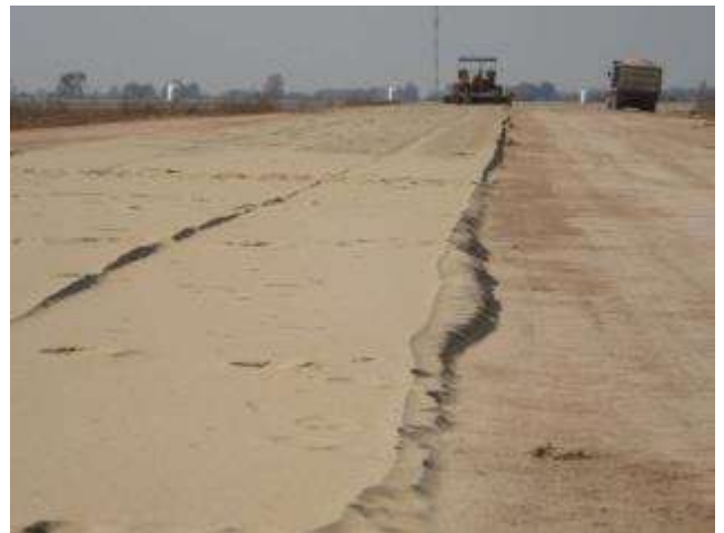
Foto 2: Distribución de arena con extendedora de asfalto.
