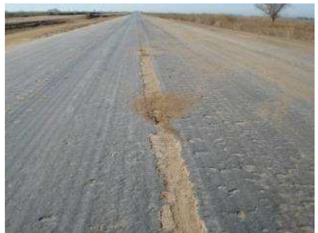
Foto 5: La falta de solapes adecuados entre las distintas fajas de trabajo del reciclador, puede generar juntas longitudinales de material sin tratar.
