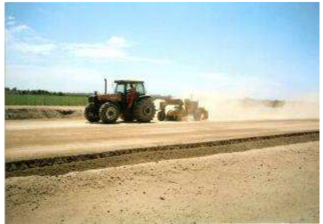
Foto 10: Barrido y soplado de la superficie, previo al riego de curado.
