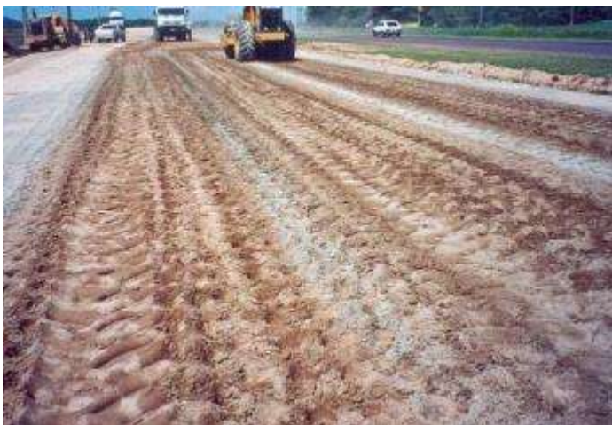
Foto 5: La falta de solapes adecuados entre las distintas fajas de trabajo del reciclador, puede generar juntas longitudinales de material sin tratar.
