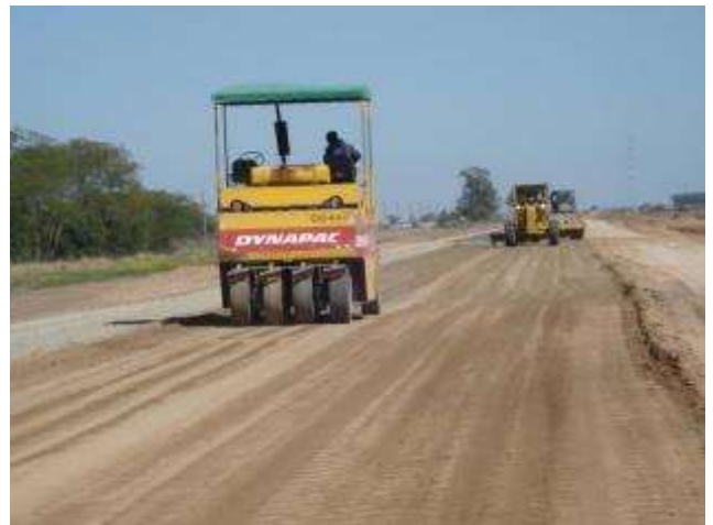
Foto 7: Sellado final con rodillos neumáticos.
