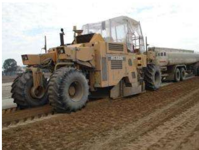
Foto 1: Equipos recicladores - reclamadores en la construcción de bases de suelo cemento.
