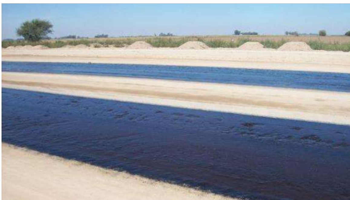
Foto 12: Canchas de suelo cemento terminadas y curadas.
