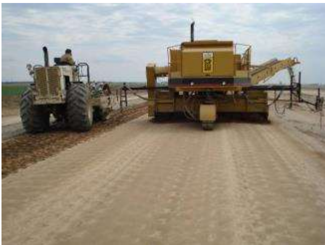
Foto 8: Trimmers en la construcción de bases cementadas.
